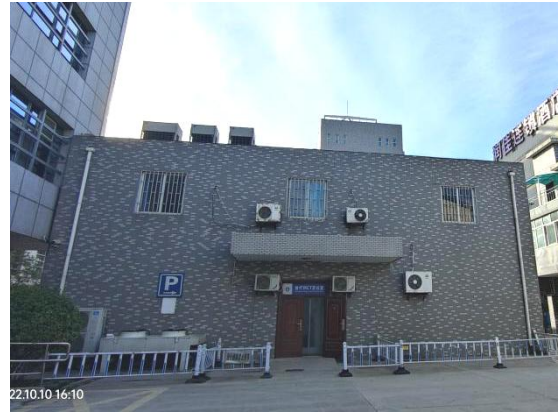
图8.1-2：放疗楼外景（后装机房入口）
