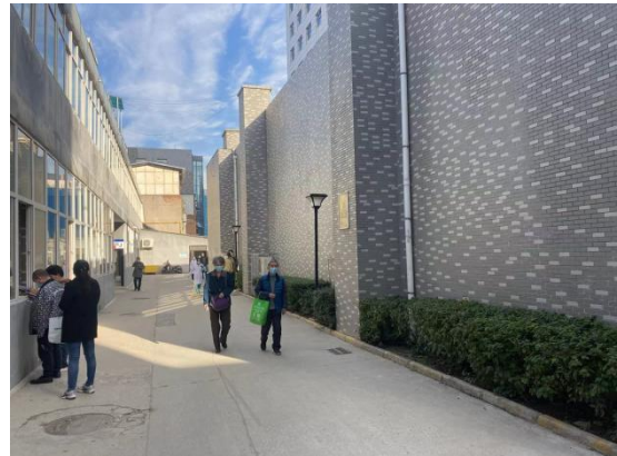
图8.1-4：后装机房北侧院内路
