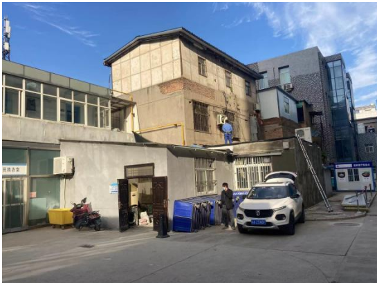
图8.1-3：后装机房机房东侧院内路
